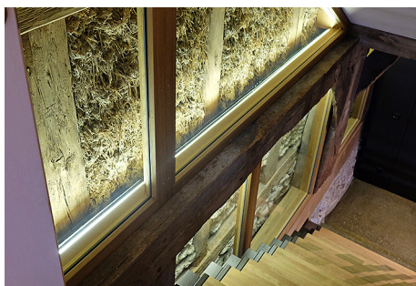
Brandschutzmauer bei der Treppe.
